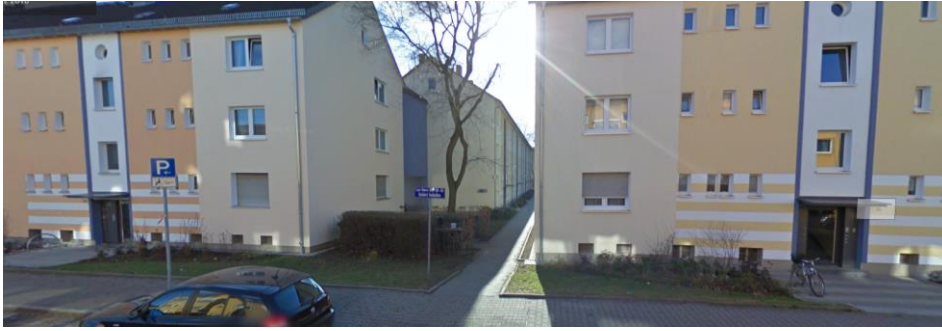
Abbildung 3: Wohnanlage Stadt Frankfurt am Main (GoogleMaps)
